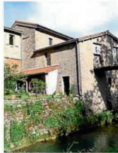
Les ateliers côté rivière.
